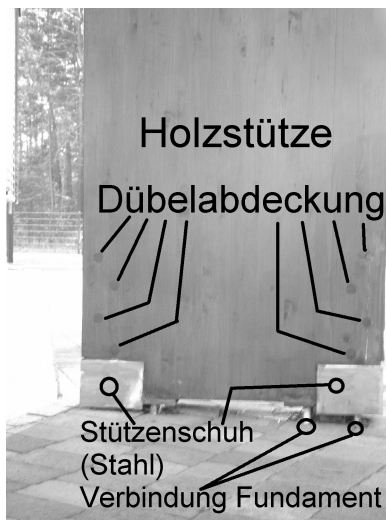
Abbildung 5: untere Befestigung der Stütze
